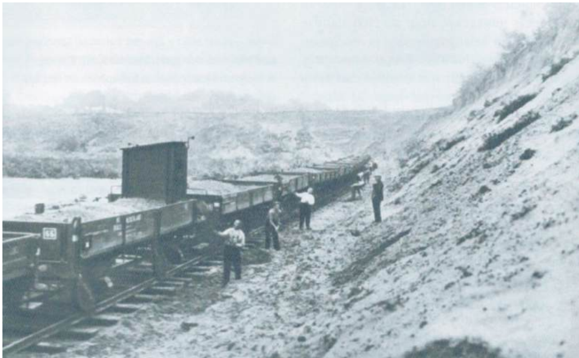
■ Zandafgraving tussen Bussum en Hilversum.
